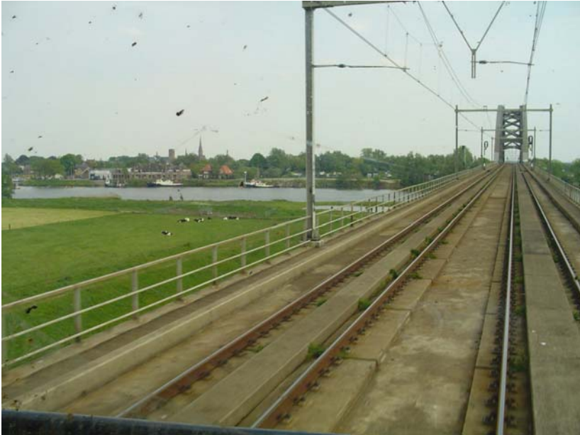
de brug over de Lek bij Culemborg
